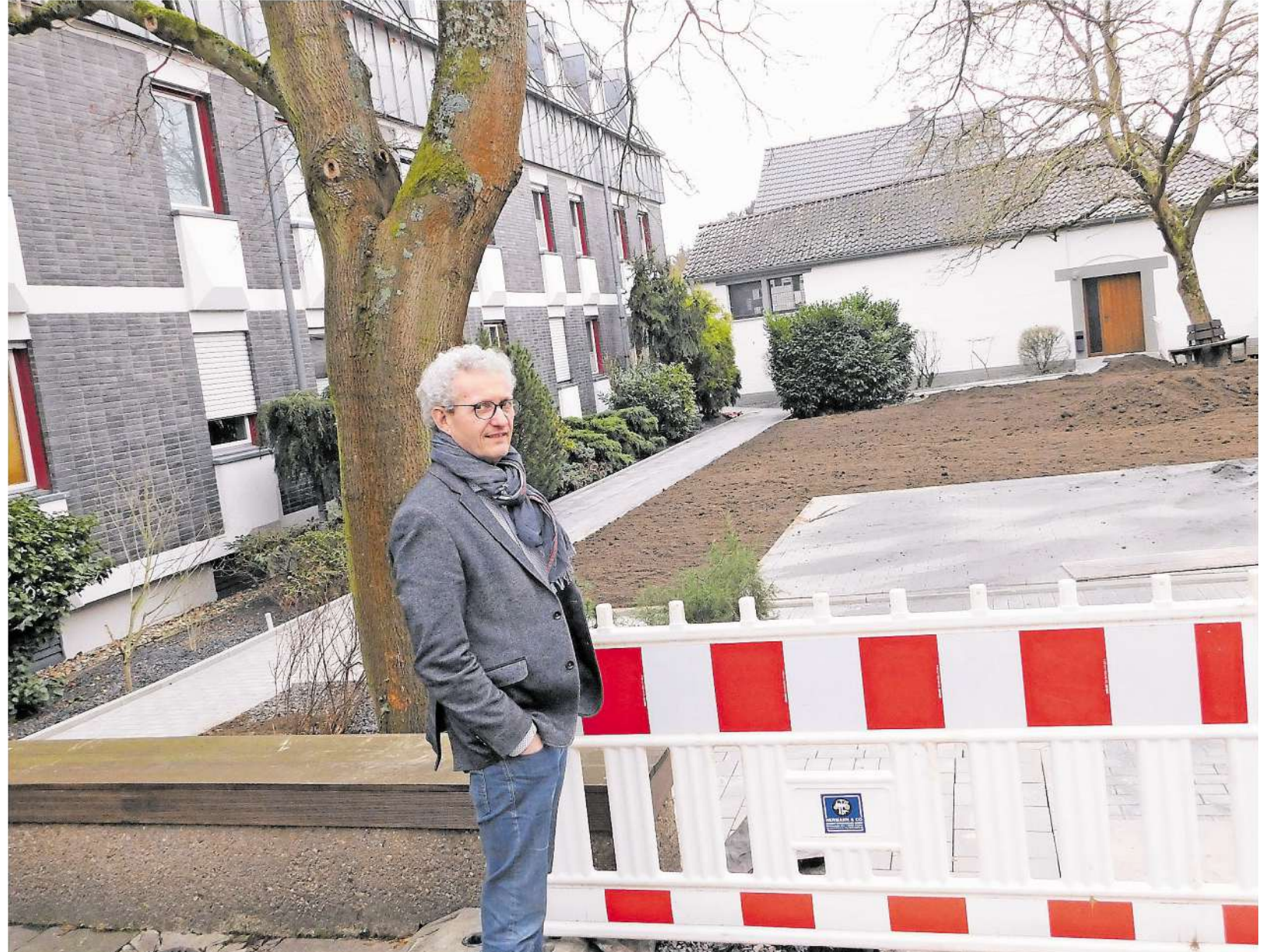
Der kleine Garten vor der Kapelle ist kaum wiederzuerkennen. Hausleiter Manfred Körber begutachtet den Baufortschritt.
